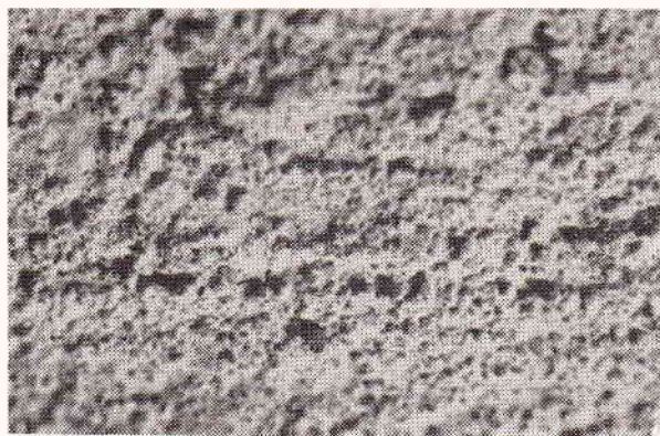
Ryc. 4. Nawierzchnia betonowa średnioziarnista z piasku 0—2,0 mm zatarta na ostro (typ C)
