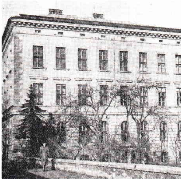
1. Budynek, w którym mieści się Katedra Parazytologii Wydz. Wet. w Brnie.
